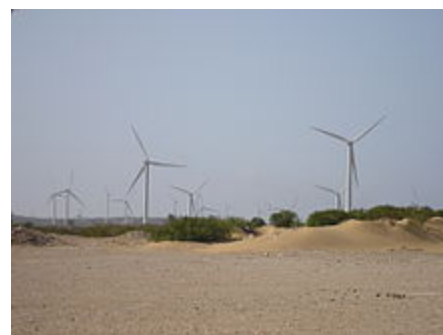
Parc éolien d'Amogdoul près d'Essaouira au Maroc.
