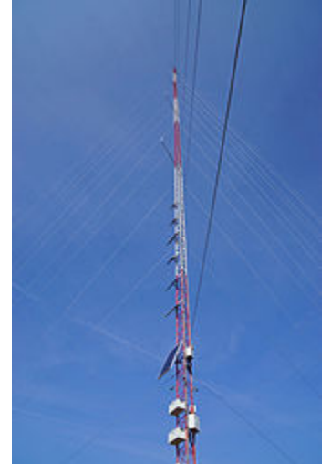
Un mât de mesure permet de connaître le potentiel éolien.
