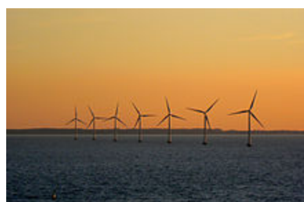
Éoliennes en pleine mer au large du Danemark.
