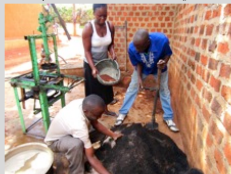
Mélange manuel sur une dalle de ciment (Arise - Ouganda)
