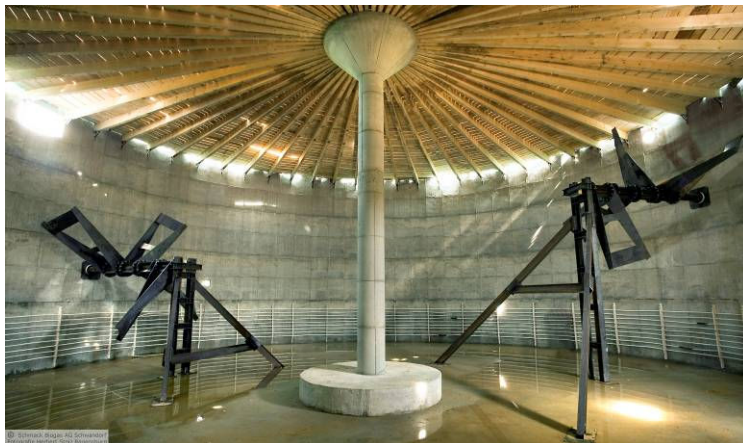
Photo 4: réacteur continu infiniment mélangé - intérieur d'une fosse/digesteur pour effluents d'élevage – Schmack (A)
