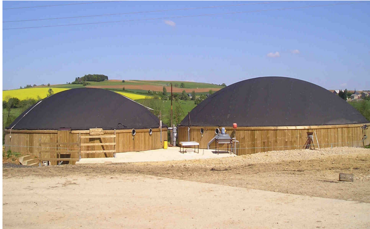
Photo 3: réacteur continu infiniment mélangé - fosses digesteur/gazomètre - installation du GAEC Oudet (F)
