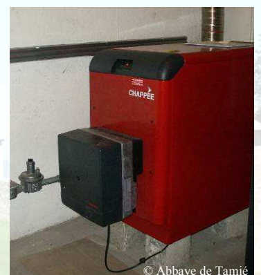
La chaudière à biogaz
