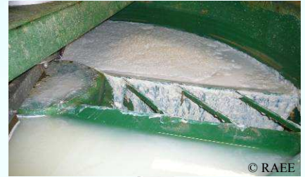
L'aéroflottateur vue de dessus
