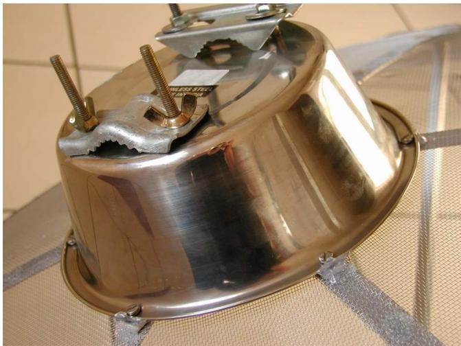
**Figure 9: Fixation arrière du réflecteur**
