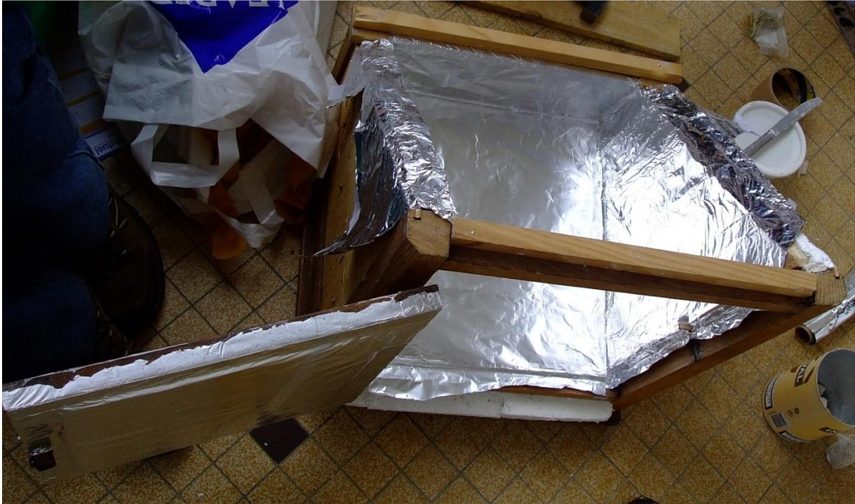
Viens en parallèle, **l'isolation de la porte et la mise en place de l'aluminium.**
