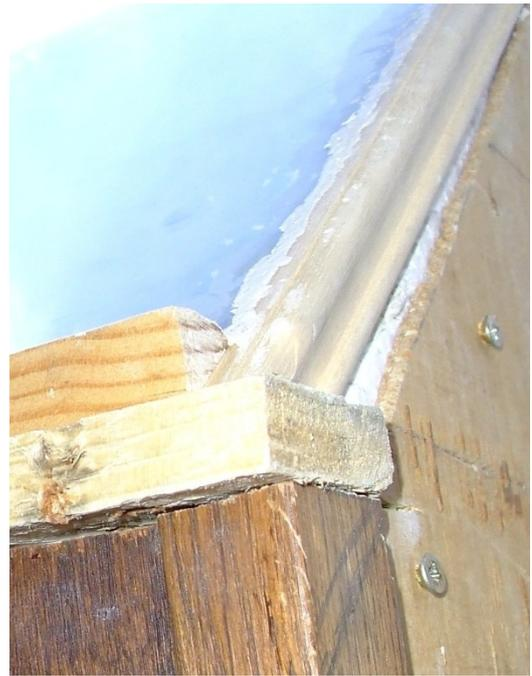
Nous avons renforcé la structure avec des plinthes et remastiqué le tout parce que le pot de mastic nous le permettait !
