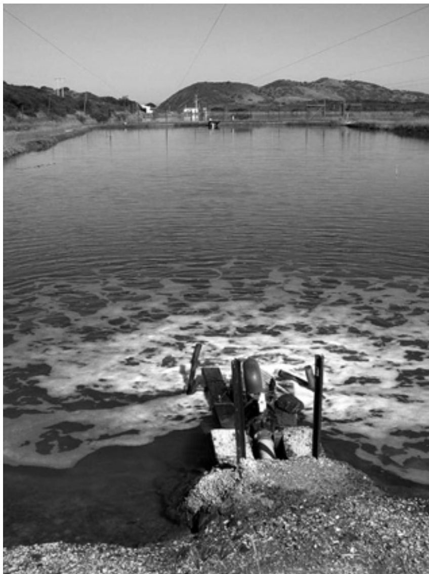
Figure 51. Bassin en terre idéal pour l'installation de hapas et bag nets .
