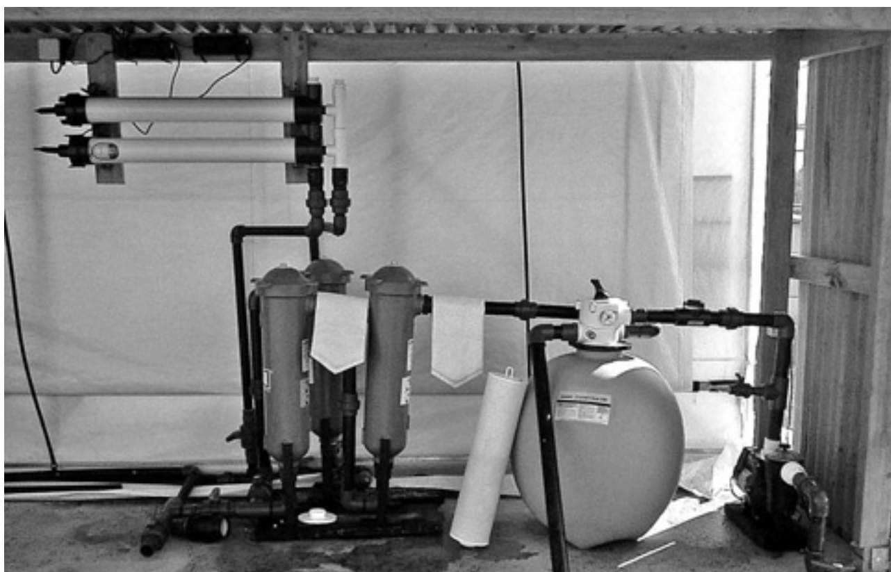
Figure 34. Système de filtration de l'eau de mer.
