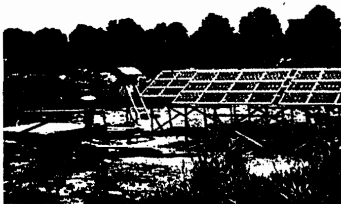
Photos 15 — Pompe utilisant l'énergie captée par un ensemble de piles photovoltaïques
