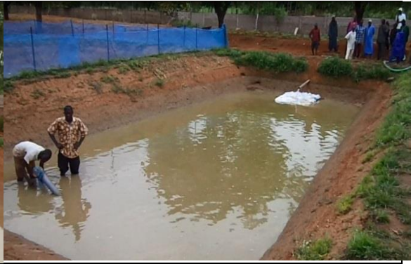
Les tuyaux de vidange et de trop-plein sont ajustés pour régler le niveau d'eau maximal.
