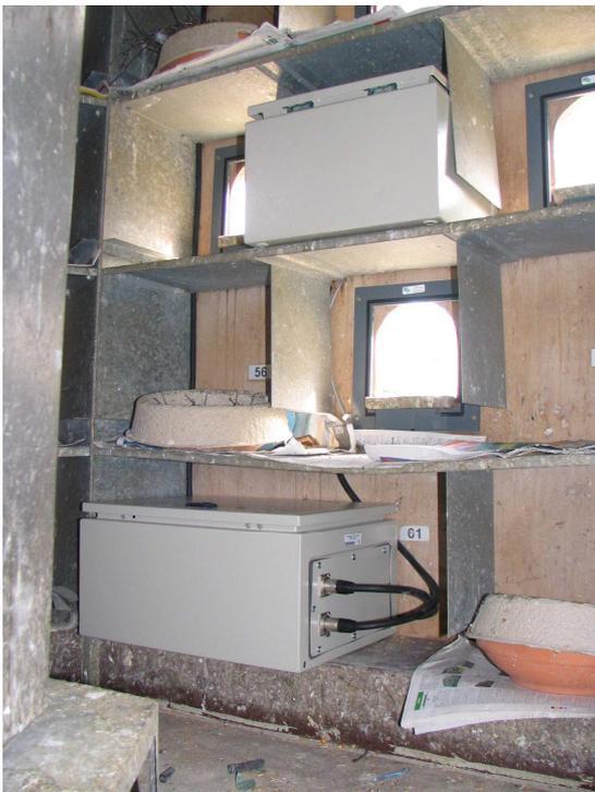
**Fig.23** : Coffret de lecture, antennes autour des portes et batterie en bas
