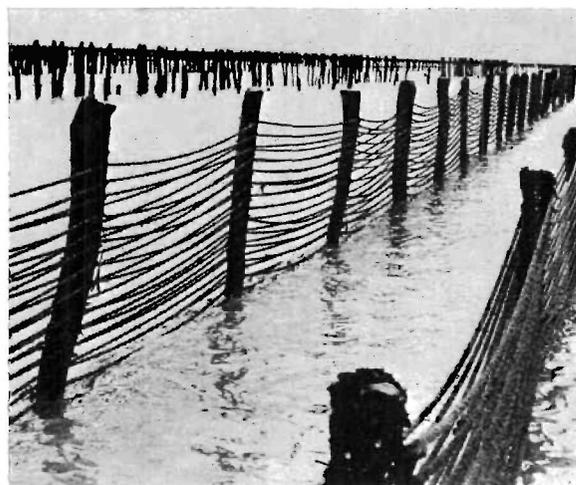
FIG. 79. — Bouchot à cordes dans le pertuis Breton.
