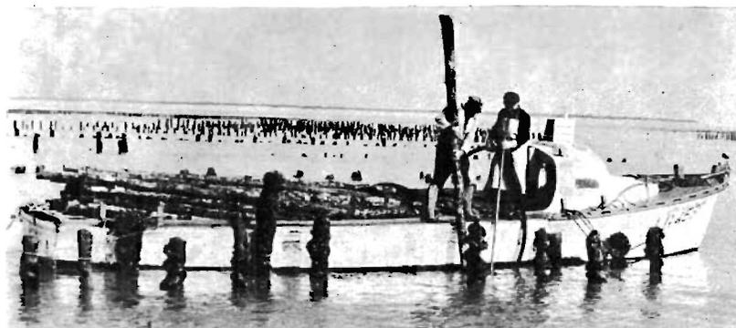
FIG. 77. — Plantation d'un pieu à l'aide d'une motopompe; l'un des hommes ayant déjà préparé le trou à l'aide de la lance, l'autre s'apprête à mettre le pieu en place (photo A. PERREAU, L'Aiguillon-sur-Mer).
