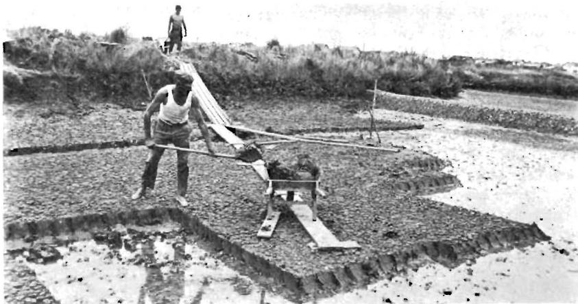
FIG. 64. — Les travaux annuels d'entretien n'empêchent pas l'exhaussement du fond qu'il faut donc périodiquement recréuser ; c'est l'opération du piquage (photo R. MET).
