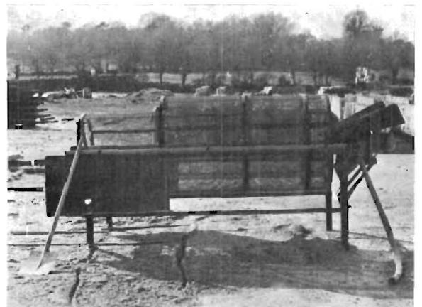
FIG. 21. — Crible à tambour rotatif.
