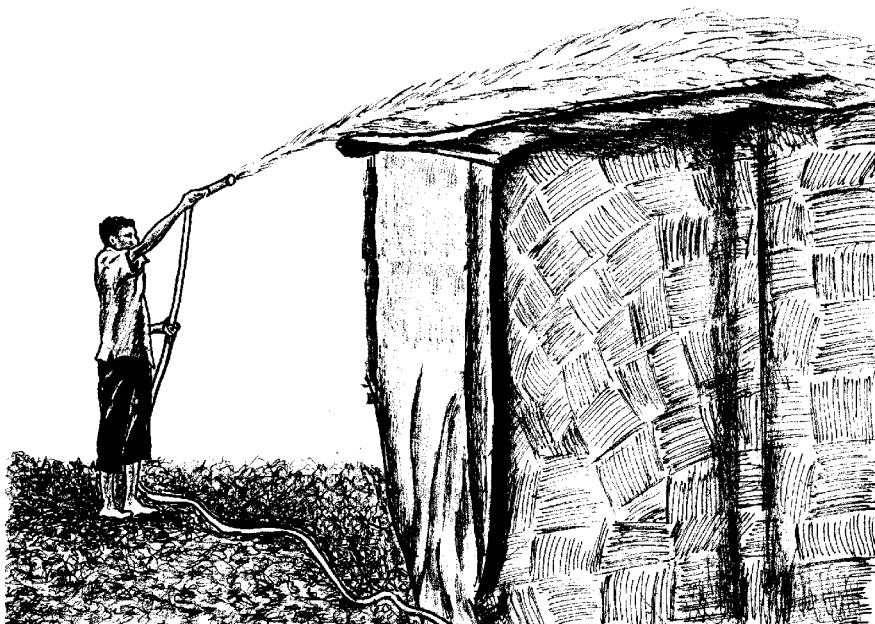
Figure 26 : Arrosage du tissu recouvrant le toit
