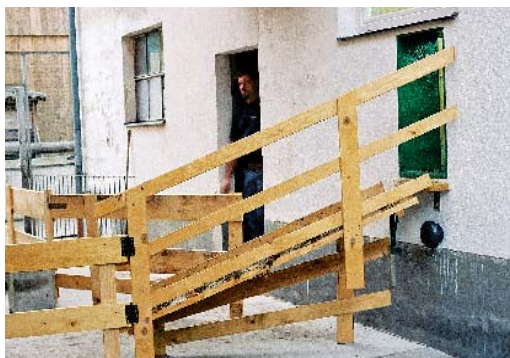
L'accès à la salle de traite peut être une simple rampe en bois.
