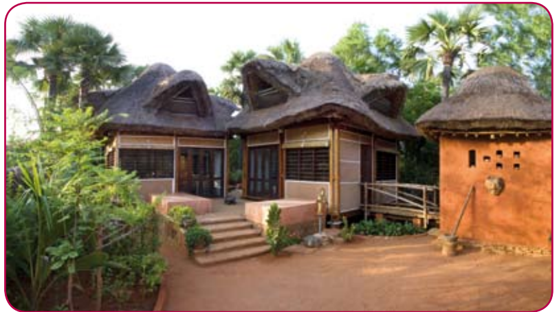
Centre de formation de Pebblegarden, en terre crue, en bambous et en toit végétal
