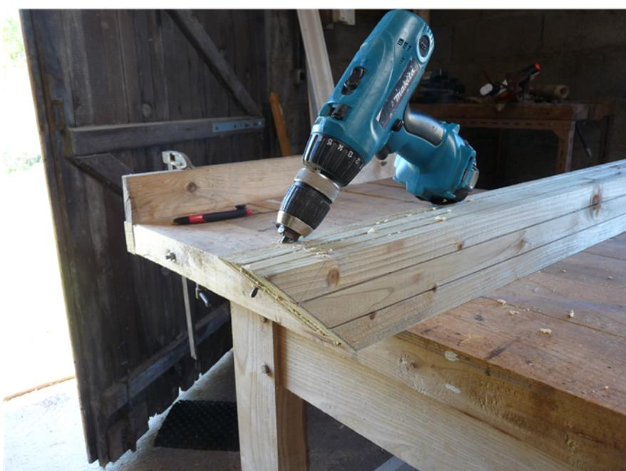
**Percez à 45° les lames de terrasses à 6 cm du bord avec une mèche de 4mm.**
