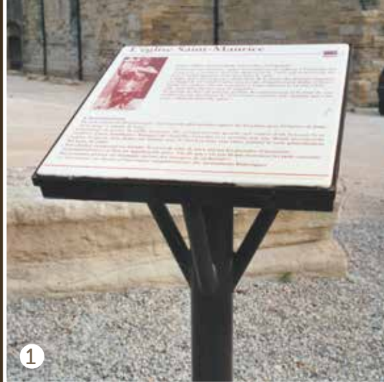
1 • Pupitre en acier, structure mécano-soudée, plateau lave émaillée
