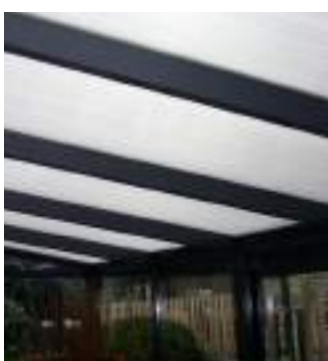
Toiture en polycarbonate
