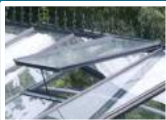
Lucarne de toit
