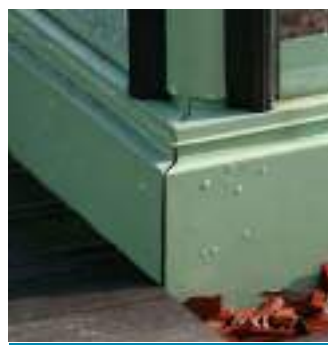
Base : socle sur lequel vient se poser la serre
