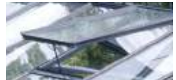
Ouverture automatique de lucarne
