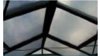
Toiture en polycarbonate 16 mm
