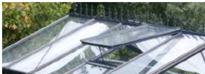
Ouverture automatique de lucarne
