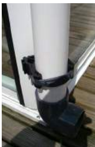
La descente de gouttière
