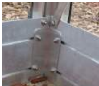
Base : socle sur lequel vient se poser la serre
