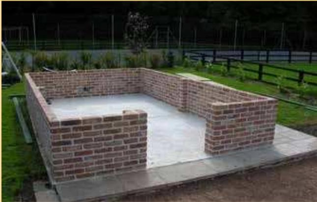
Une fois que vous avez choisi la taille de votre serre, construisez le mur aux dimensions les plus proches possibles de celles choisies (dimensions extérieures). Nous autorisons une différence de 0 à 70mm pour correspondre aux différentes tailles de briques, de joints de mortier, etc. Une fois que le mur aura été construit, nous vous demanderons de nous transmettre ses dimensions extérieures et sa hauteur au niveau de la porte.
