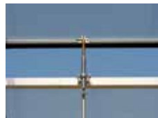
SPINDLE Vis sans fin pour ouvrir et fermer les lucarnes de toit
