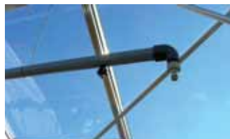
Rampe de brumisation
