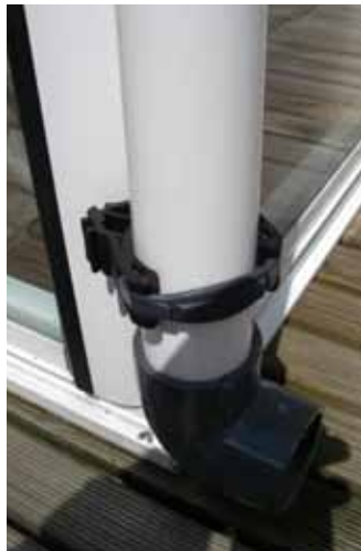
La descente de gouttière
