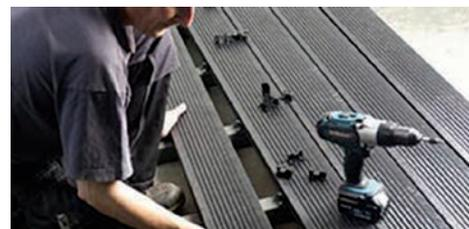
Sur-mesure : platelage 100% plastique recyclé composé de planches antidérapantes. Elles se fixent à l'aide d'agrafes sur un chevronnage également en plastique recyclé. Ce produit vous offrira une tenue dans le temps inégalable (imputrescible).
