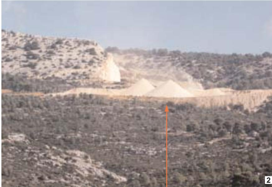
Un exemple d'impact paysager généré par les pistes et les stocks, alors que l'excavation est correctement calée dans le relief et développée en gorge en arrière d'un versant préservé.
