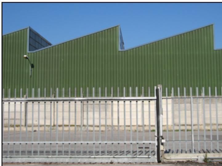
Avec la motorisation autoportante, un rail au sol n'est pas nécessaire. Cela peut être une solution lorsque l'installation d'un rail se révèle difficile, voire impossible (passage fréquent d'engins lourds, terrain meuble, etc.). Ce système était prévu à l'origine pour les sorties d'usine, mais il se décline également pour les particuliers.
