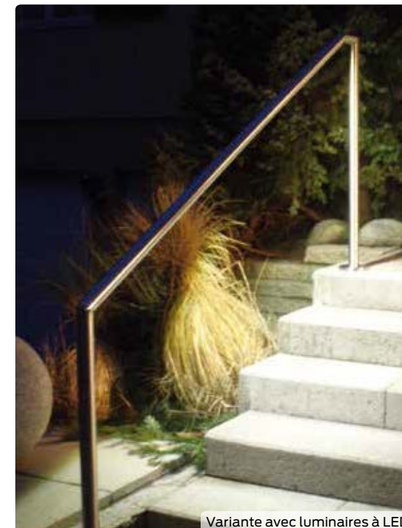
Variante avec luminaires à LED
