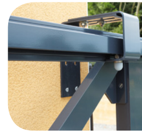
Système de guidage du vantail
