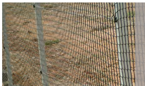
Poteaux en matériau composite avec plats de fixation
