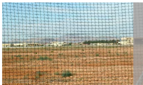
Filet polyéthylène de la clôture amagnétique
