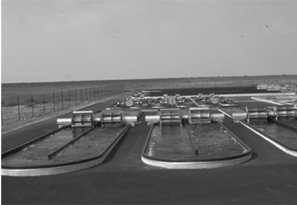
**Figure 3** : Système de culture en extérieur du type Raceway (Société Inovalg (85))
