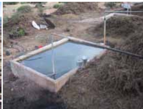
4. Bassin de refroidissement
