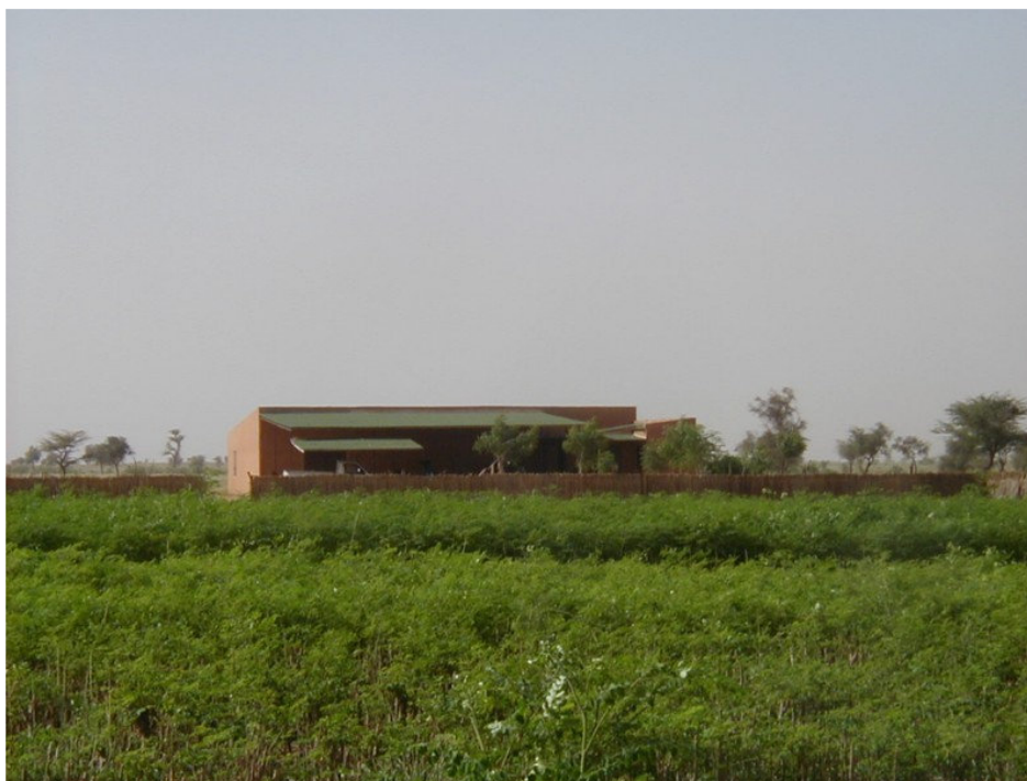
Bâtiment de transformation et plantation de Moringa
