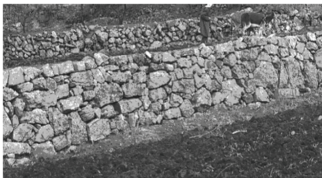
Photo 1. Murette permettant l'irrigation par gravité de la parcelle aménagée
