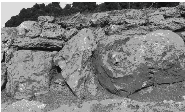
Photo 2. Blocs métriques à la base de la murette, permettant sa stabilité et l'évacuation des eaux en excès
