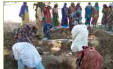
Réalisation des fosses à compost, Niger
