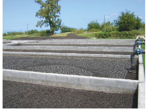
Lit de séchage des boues de station d'épuration à Saint-Leu. © V. van de Kerchove
