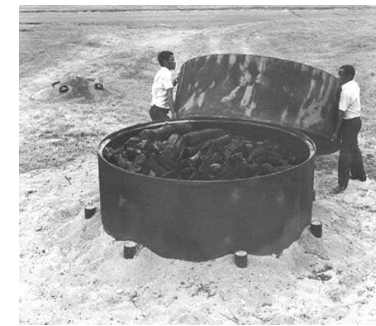
Le démontage de la cuve
