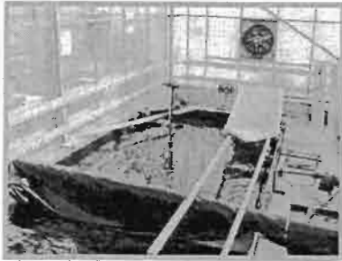
Construction du bassin
