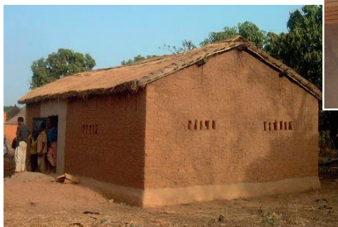
Case avec toit de paille et ventilation
