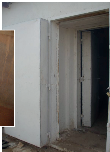
Doubles murs et portes isolées, Bandiagara Mali
