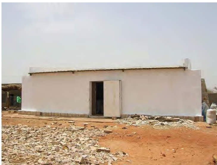
Nouvelle chambre froide de YA-G-TU, Bandiagara, Mali
