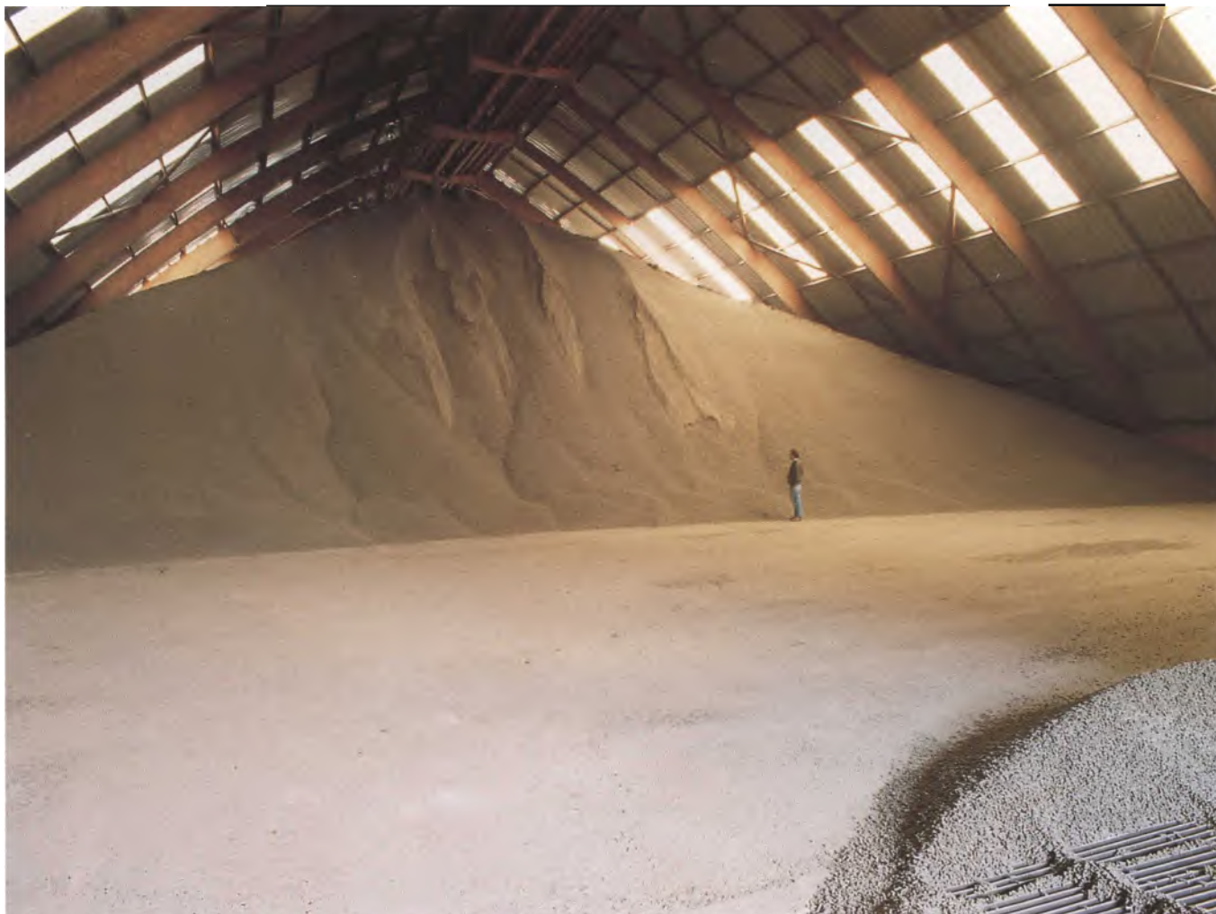
STOCKAGE DE LA FÉCULE CHEZ AVEBE FRANCE.
