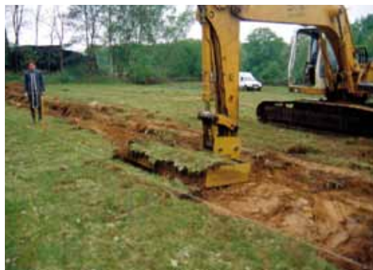
➤ Des banquettes de végétation sont déplacées par une pelle mécanique en vue de les redéposer sur le site désiré. Source : Ecosphère, mai 2001
