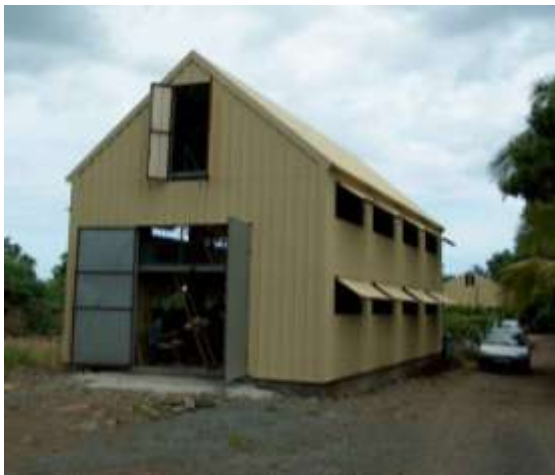
Photo 5 : Séchoir en tôle sur trois étages (La Possession)
