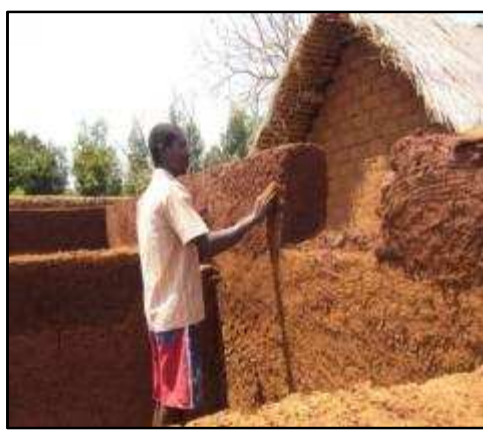
Photo 9 : Elévation du mur en pisé (Betroka) Source : auteur, 2010
