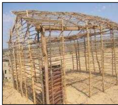
Photo 10 : Charpente en bois pour un sol plus sableux Source : auteur, 2010
