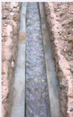
Photo 7. Canal d'irrigation en béton
