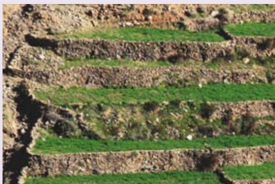
Photo 6. Aménagement en terrasses d'un terrain en pente
