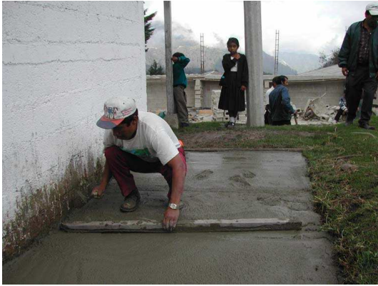
Préparation de la dalle en ciment
