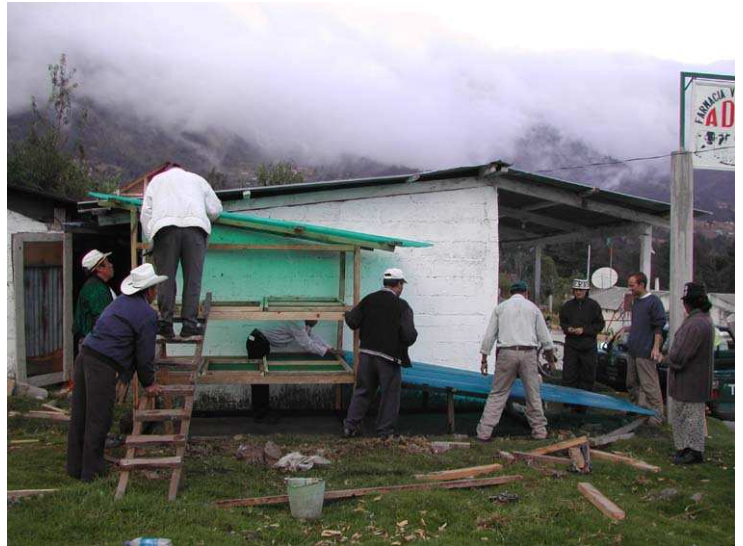
Assemblage des deux parties (chambre de séchage et collecteur)
