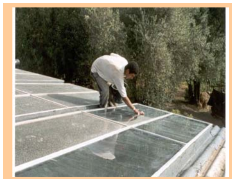
Photo 8 : Entretien des panneaux solaires
