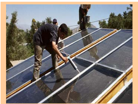
Photo 7 : Montage des panneaux solaires
