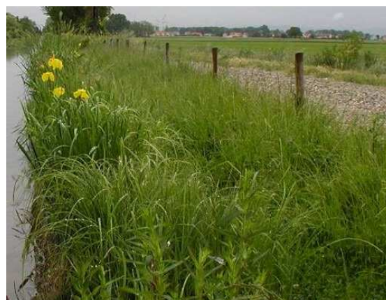
Exemple de protection de berge par fascine d'hélophytes
