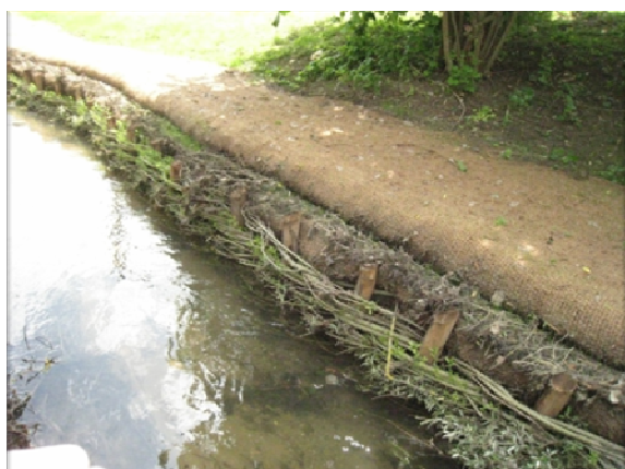
Exemple de protection de berge par tressage
