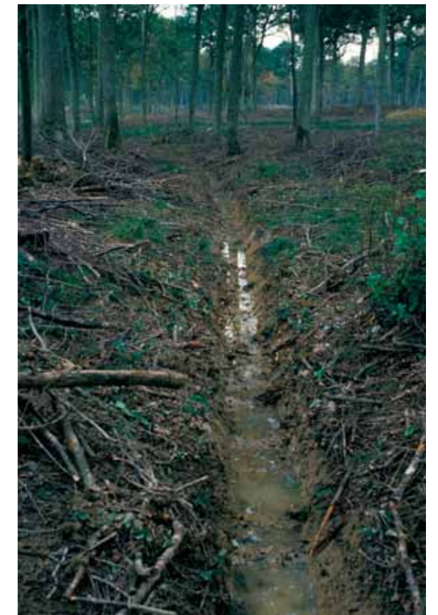
Entretien de fossé
