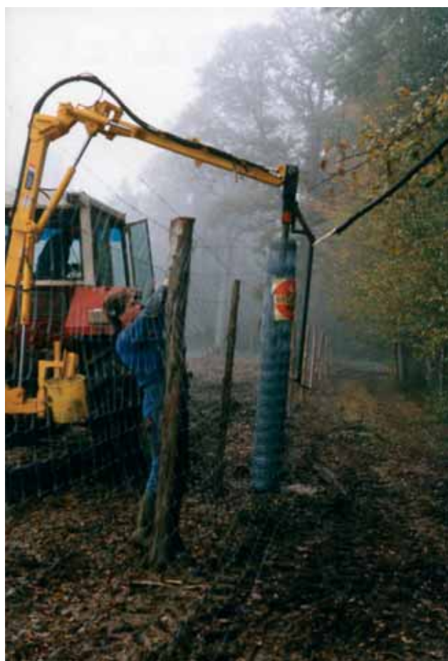
Installation d'une protection globale.
