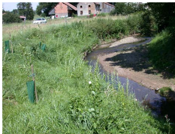
Exemple de plantations en berge « retalutée »
