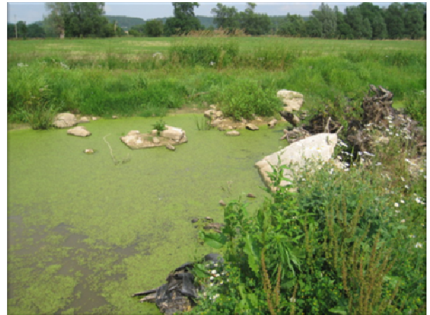
Exemple de dégradation fréquente : comblement par dépôt de matériaux
