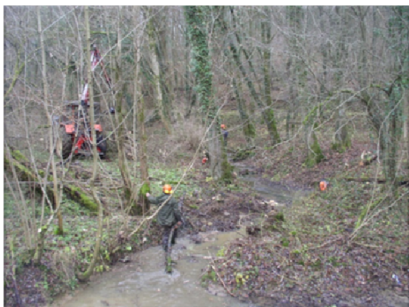
Travaux en cours de coupe sélective de la végétation
