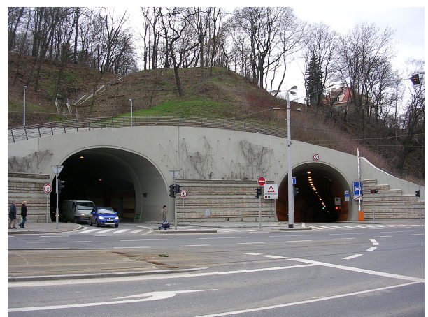
Localement, des aménagements en tunnels permettent de conserver des zones vertes continues, jouant le rôle d'écoducs. Ceux-ci permettent à de nombreuses espèces de traverser les axes de transports, souvent très fréquentés aux abords des villes (ici le Tunnel Mrázovka à Prague en République tchèque).
